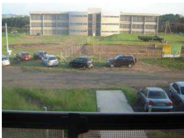
Foto 31- Edificações no início das obras em 2011 para construção do departamento de Engenharia Elétrica
