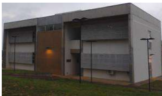
Foto 33 - Prédio do Departamento
