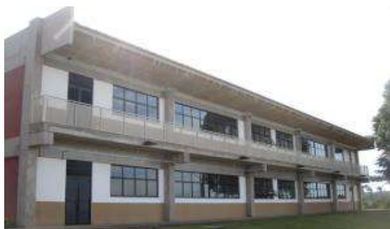
Foto 32 - Prédio de laboratórios
