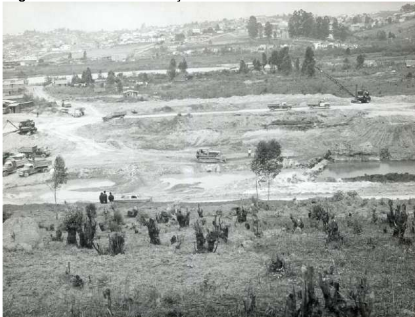
Figura 2: Obras de retificação do Rio Tietê. S.d. São Paulo - SP.
